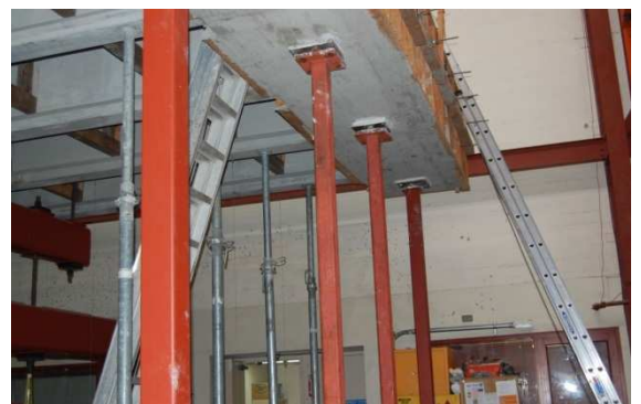
(d) Temporary abutment support
